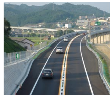
②京奈和自動車道「五條道路」の開通(H18)
