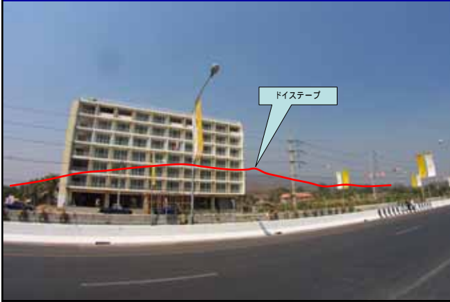
チェンマイの事例(1) キャナル通りの工事中建物
