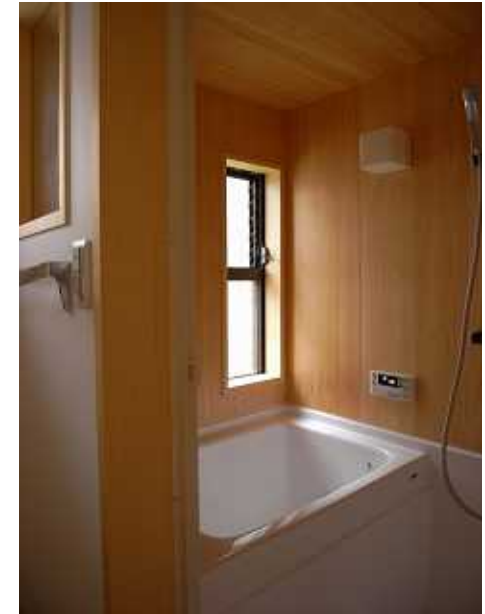
ユニットバスに桧の壁
