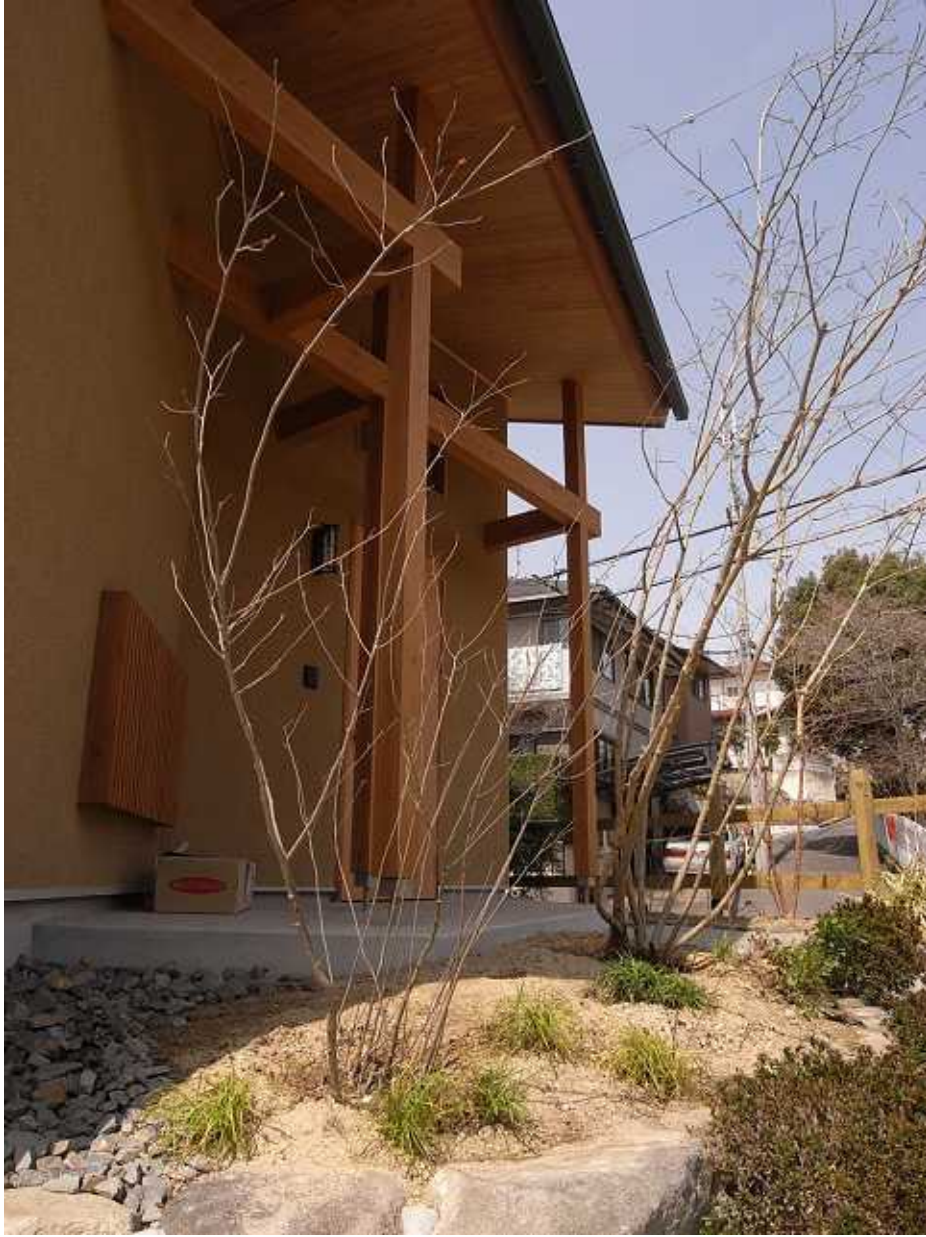
生駒山麓の家 設計:FRONTdesign 紀州産杉、檜の構造材、吉野産杉の造作材 外壁仕上げは色モルタル掻き落し
